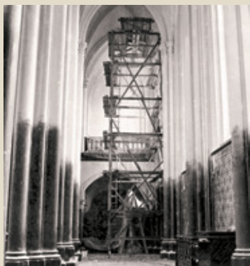
Rokiškio bažnyčios remontas
